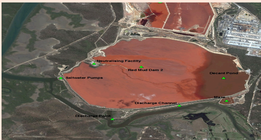
Figure 9 : Le barrage de boues rouges de la QAL
