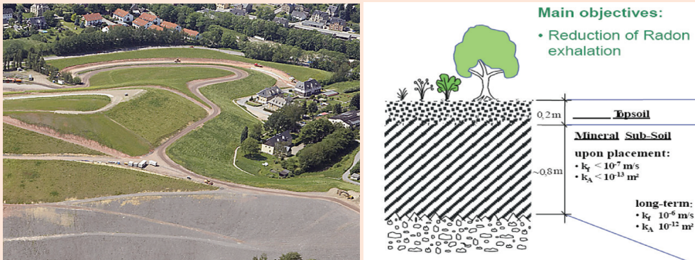
Figure 3 : Terril n° 366 sur le site de Schlema après sa réhabilitation accompagnée de mesures
