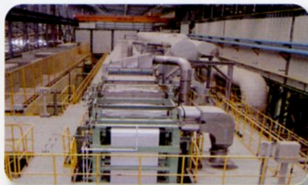
烤漆出口區 / CCL Exit
