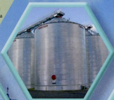
穀物筒倉 Grain Bin ▲ (鍍5%鋁鋅產品 PhuizerFan) 照片由加拿大Twister Pipe公司提供 Courtesy of Twister Pipe Ltd., Canada
